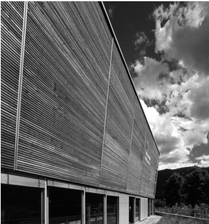
Premio Archilegno Alto Adige 2002/03 Edilizia pubblica 1° Premio: Bocciodromo coperto Progetto e direzione lavori: arch. Paolo de Martin
